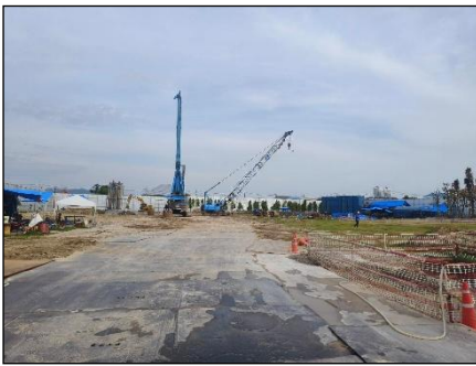
รูปที่ 13 แผ่นเหล็กสำหรับทางวิ่งรถ
